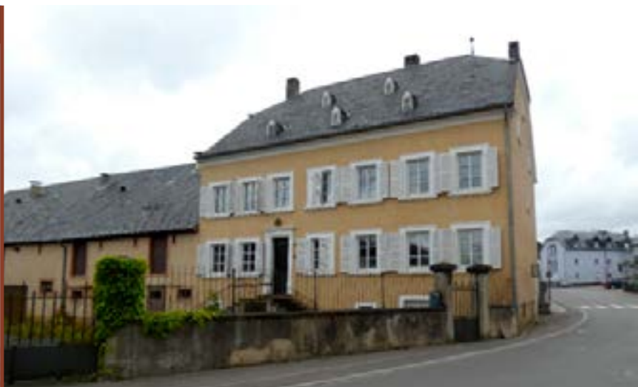
Ancienne ferme à Tandel, classée
