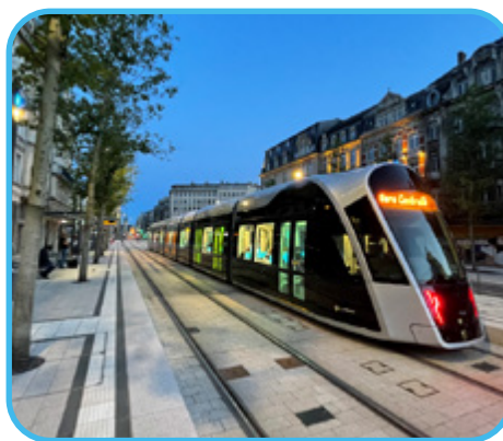
Figure : Tram à hauteur de l'arrêt Place de Metz
